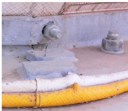
Revisión de estanqueidad
